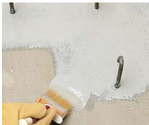
Нанесение Eporip кистью на рабочий шов бетонирования
