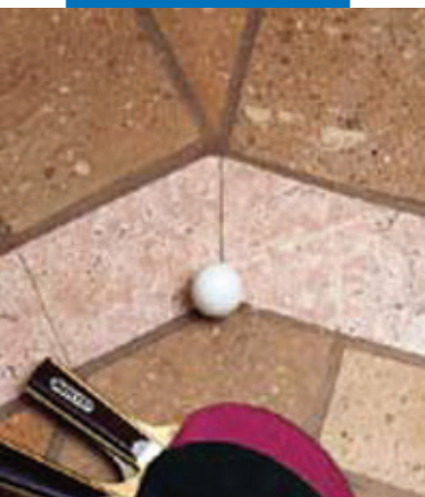
Полированные терракотовые полы, затертые Keracolor FF замешанным на Fugolastic .
