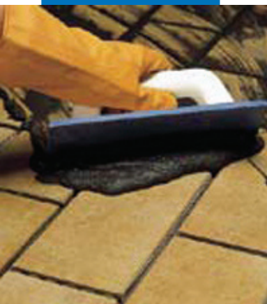
Заполнение швов снаружи помещения в клинкерной плитке с использованием Mapeclinker , смешанным с Fugolastic .
