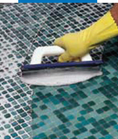
Заполнение швов в стеклянной мозаике с использованием Keracolor FF , смешанным с Fugolastic .
