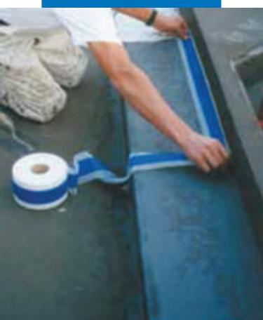
Пример гидроизоляции угла между нижней и боковой частью ванны с помощью Мареband
