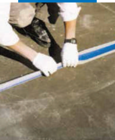
Пример гидроизоляции деформационного шва на террасе
