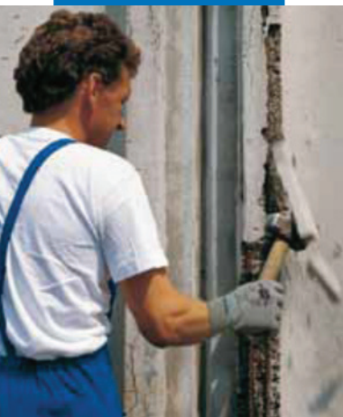
Удаление поврежденного бетона
