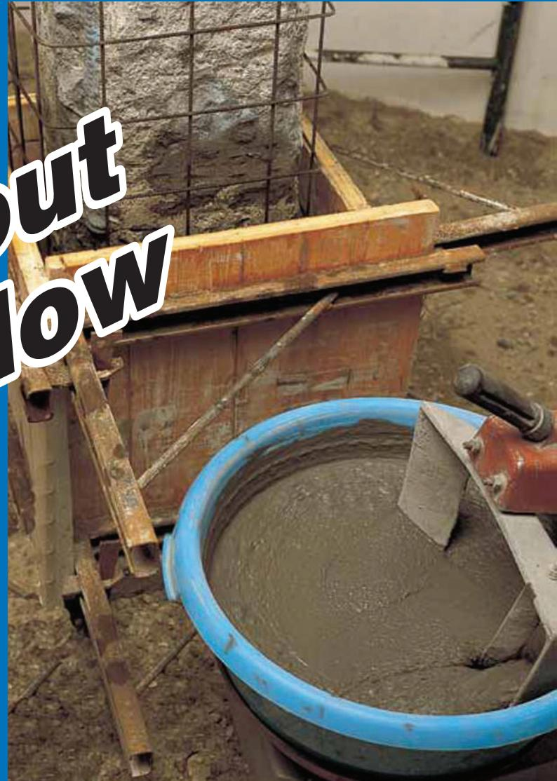
мальная фракция заполнителя 3 мм. Толщина нанесения в один слой от 10 до 40 мм.
