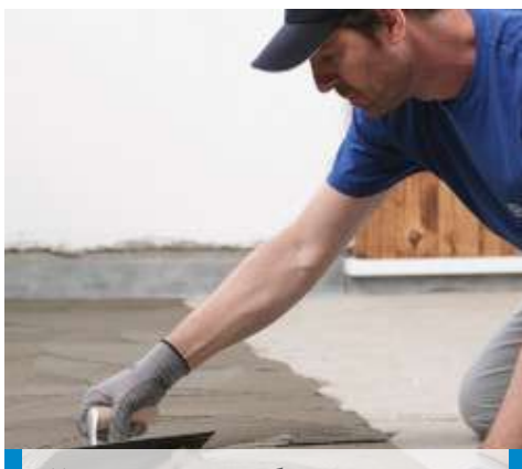
Нанесение клея зубчатым шпателем №5
