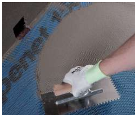
Laying Mapelastic on Mapenet 150
