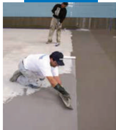
Гидроизоляция бассейна с применением Mapelastic
