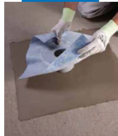
Установка вертикального дренажа на Mapelastic
