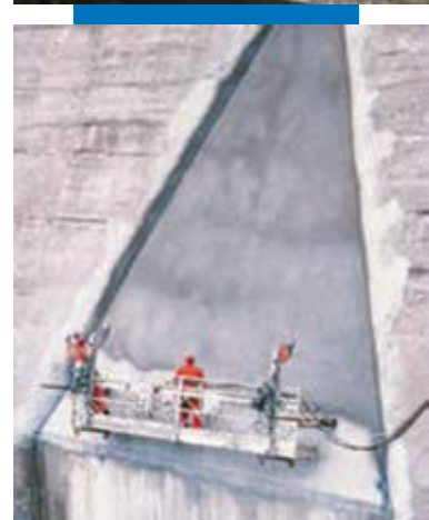
Нанесение Mapelastic на дамбу распылением
