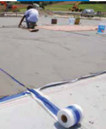
Гидроизоляция стяжки с применением Mapelastic и Mapeband
