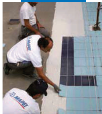
Укладка керамической плитки на Mapelastic в бассейне
