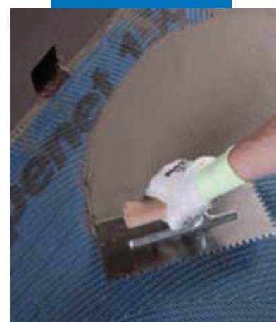
Нанесение Mapelastic на Mapenet 150 R
