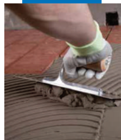
Нанесение Granirapid на гидроизоляцию Mapelastic на террасе
