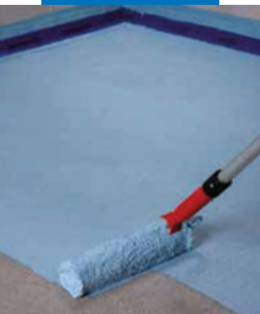
Нанесение первого слоя Mapelastic AquaDefense на стяжку
