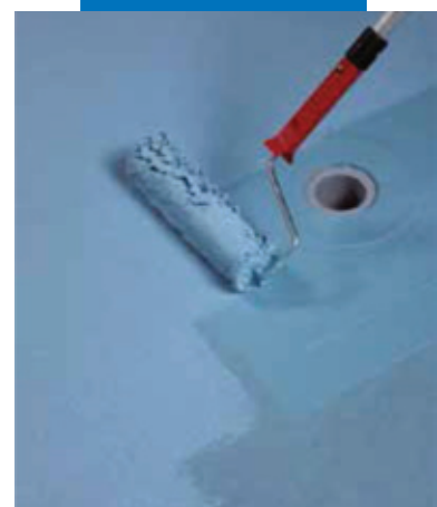
Нанесение валиком второго слоя Mapelastic AquaDefense
