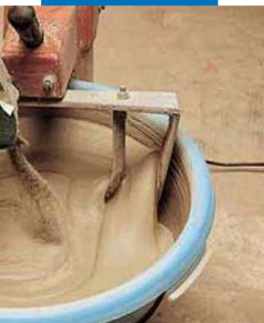
Смешивание серого Planiseal 88 с водой
