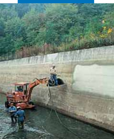
Нанесение Planiseal 88 напылением на подводный канал гидроэлектростанции
