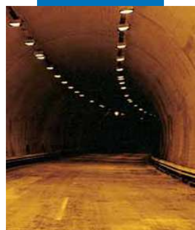
Нанесение белого Planiseal 88 напылением в автодорожной галерее
