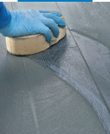
Окончательная очистка плитки с помощью целлюлозной губки
